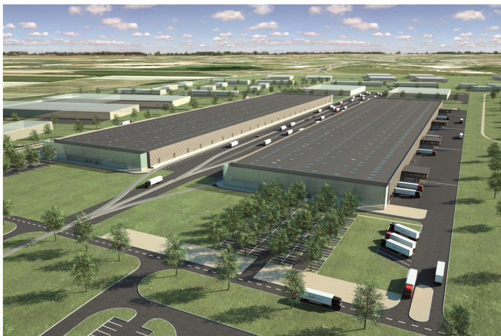
Vue d'artiste du projet CALAIS PREMIER, avec, au centre, les installations de l'entreprise CargoBeamer France.
