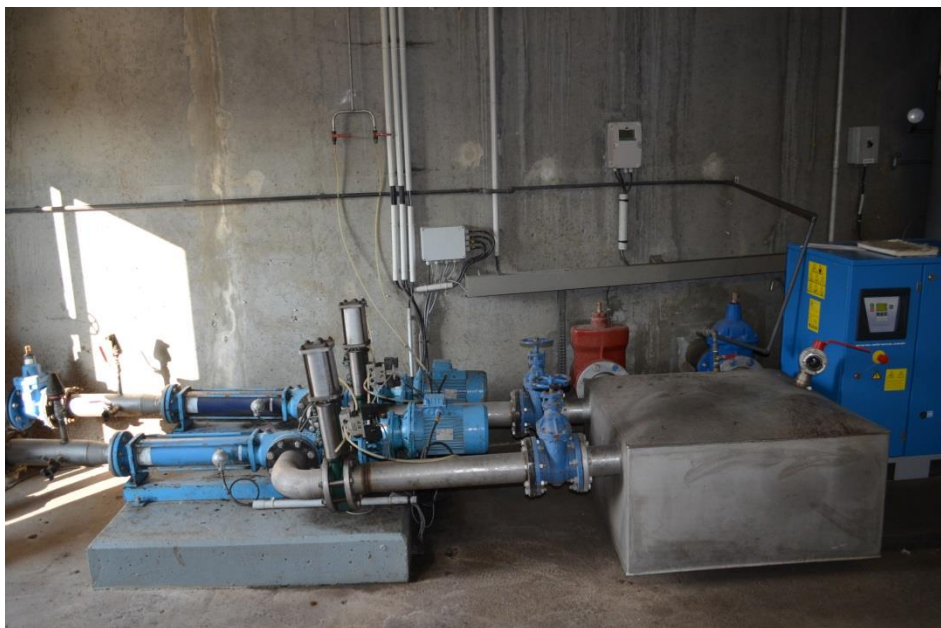
Pompe alimentation cuve de mélange
