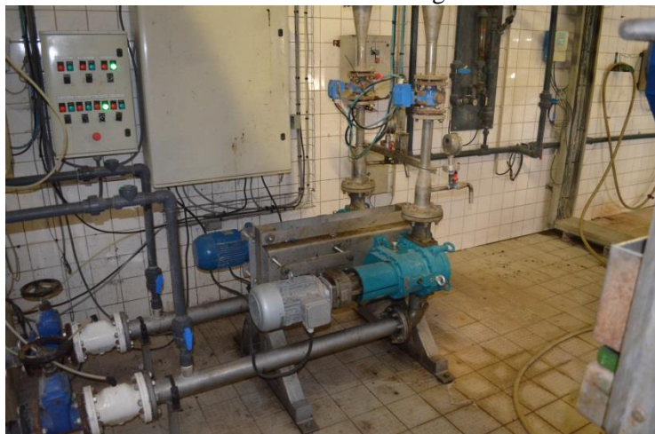
Pompes alimentations centrifugeuse
