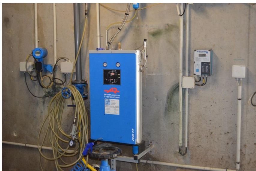
Assécheur réfrigéré
