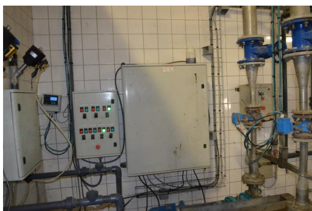
armoire de commande des pompes borger avec les variateurs
