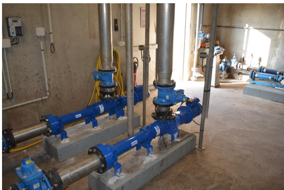
Pompe reprise des boues flottées
