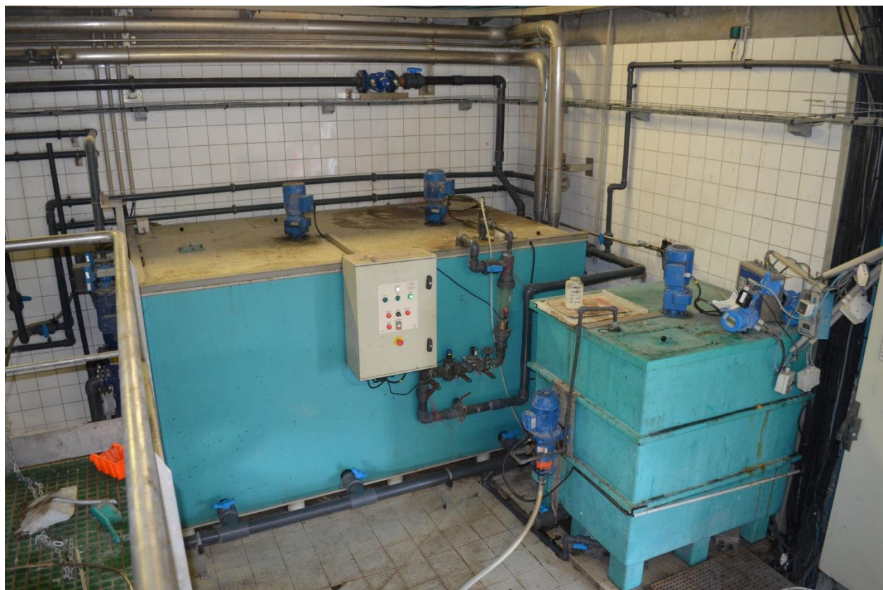
Vue cuve préparation polymère et cuve de transfert
