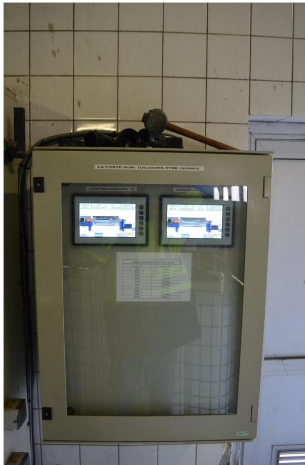
Régulation centrifugeuses
