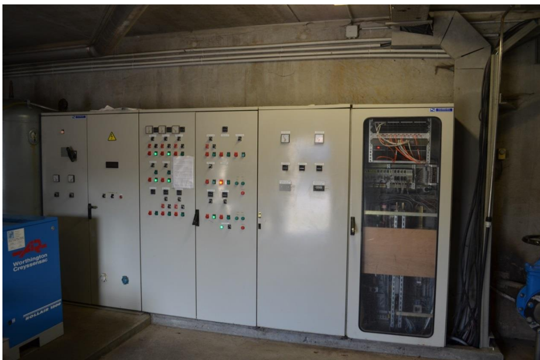
Photographie de l'armoire principale de commande dans le local flottation
