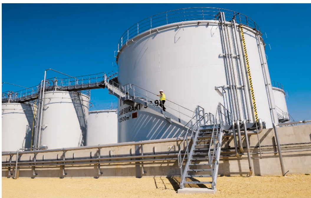
Photo 8.5. Accès et protection collective sur un silo.
