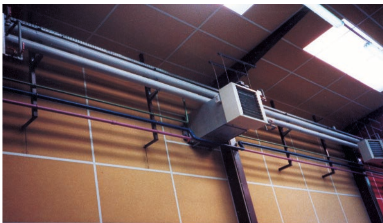
Photo 5.5. Système de chauffage d'un atelier.
