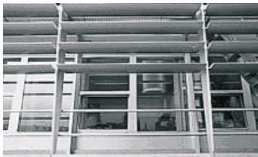
Photo 5.1. Dispositif de lames brise-soleil.
