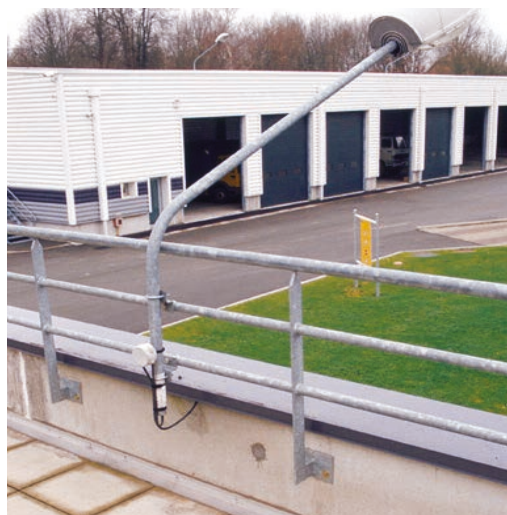
Photo 5.2. Luminaire pivotant pour le remplacement d'ampoule.
