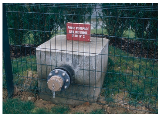
Photo 6.1.b. Prise d'eau à l'extérieur de l'enceinte grillagée.
