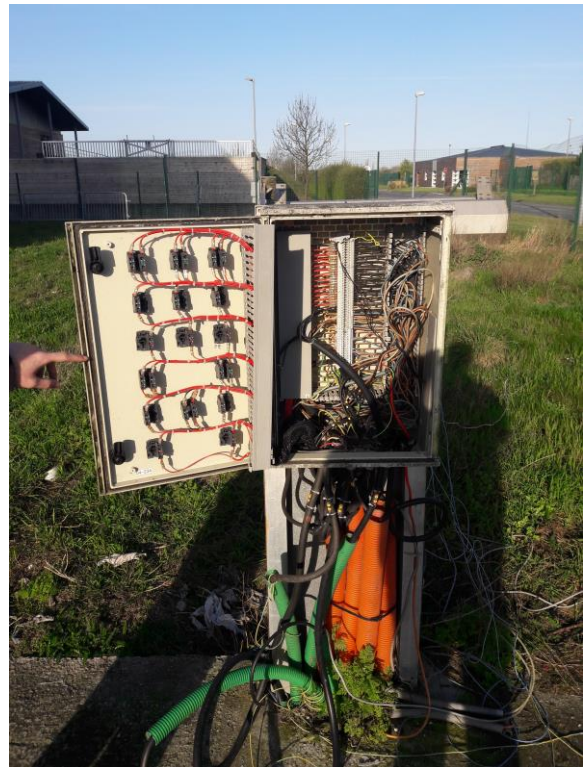
Coffret à remplacer par armoire plus grande( pour intégrer automate dégrilleur) sur socle béton
