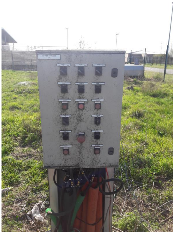
Coffret à remplacer par armoire plus grande( pour intégrer automate dégrilleur) sur socle béton
