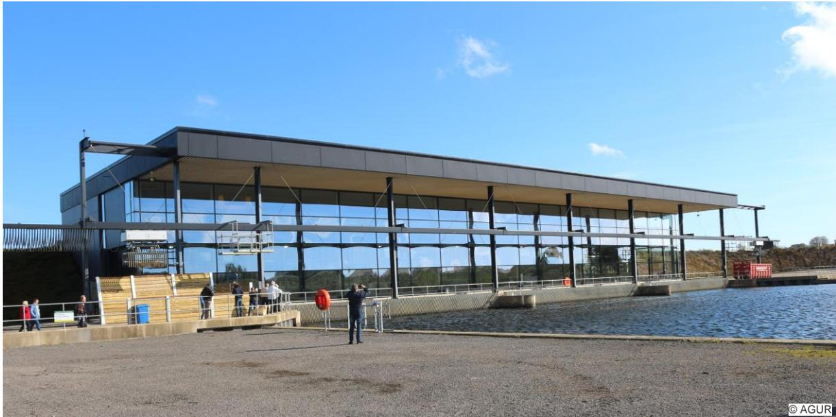
La plus grosse station de pompage du Royaume Uni. La station a été testée pour pouvoir évacuer 112 m<sup>3</sup> d'eau /seconde. Elle a remplacé une ancienne station composée de quatre pompes. En 1998 une grosse tempête a fait prendre conscience que si une des quatre pompes n'avait pas fonctionné, la région aurait été inondée. Il fallait donc augmenter la capacité de pompage. Cette nouvelle station possède donc huit pompes (6 pompes + 2 de secours).
