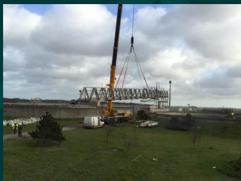
Travaux d'optimisation énergétique : les turbos (production d'air) et le clarificateur (eau traitée) de la station d'épuration Jacques Monod
