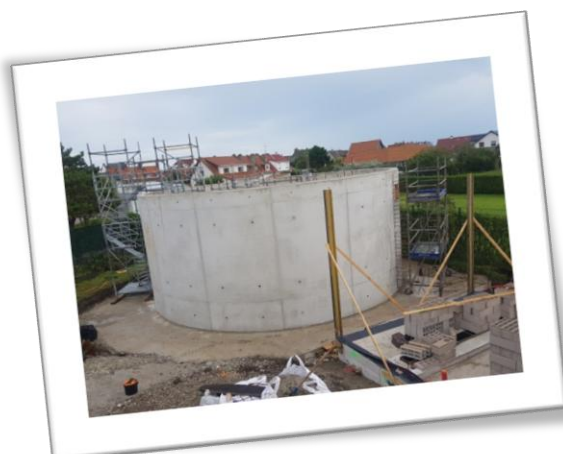
Travaux station de Sangatte 2019-2021
